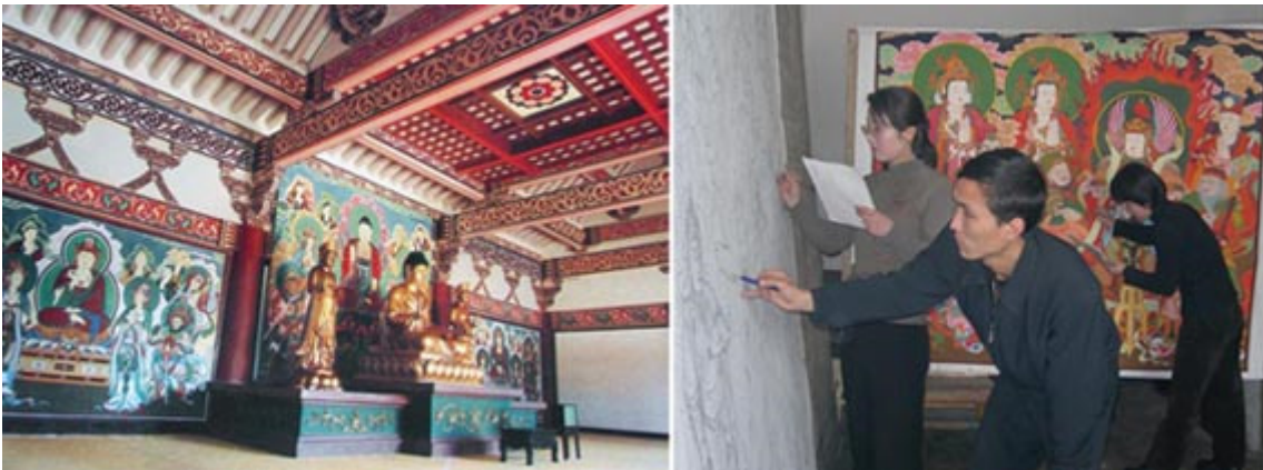
Les travaux de restauration du pavillon Pogwang du temple Jongrung du tombeau du roi Tongmyong.
